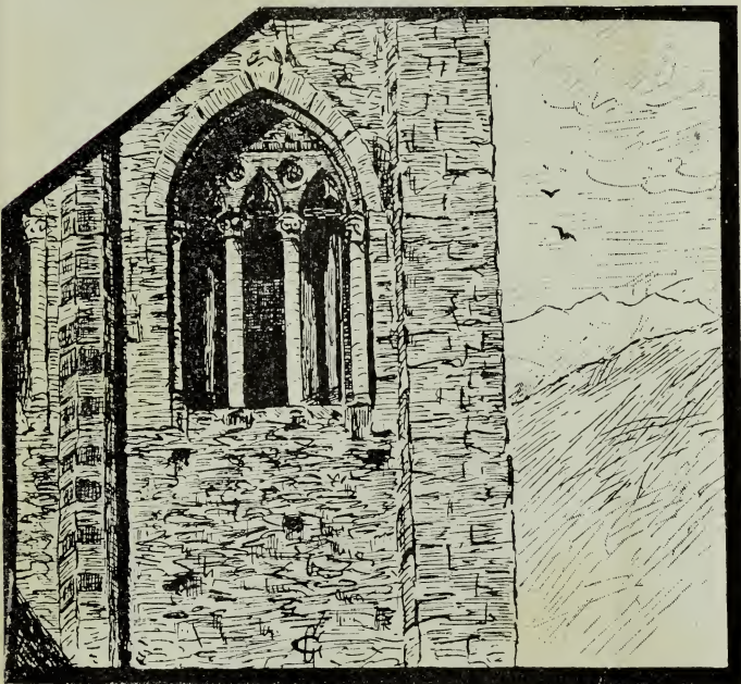
Finestra triforata del campanile.
